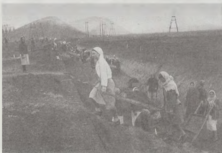
Строительство противотанковых рвов в районе Донбасса. 1941 г.
