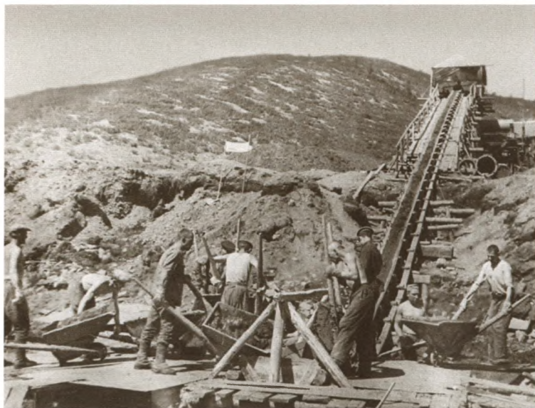
Прииск. Мускульная подача песка на промприбор
