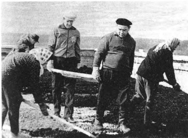
Б. Н. Ельцин и Я. П. Рябов на субботнике в Свердловске. Строительство областной больницы
