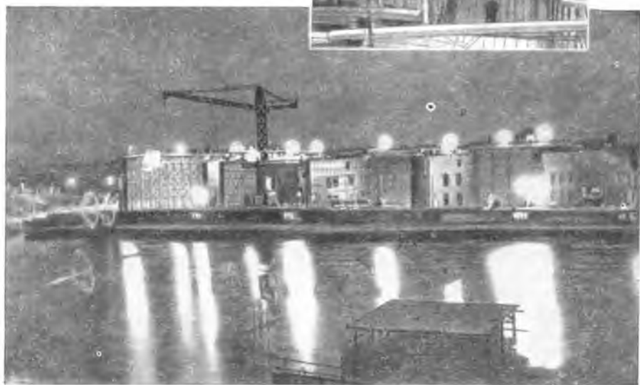
Строительство баз подводных лодок в портах Франции. Эти базы имели гигантские укрытия, обеспечивавшие подводным лодкам полную безопасность от вражеских бомб. Толщина железобетонных перекрытий равнялась 4 м.
