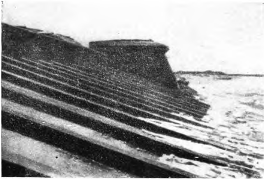
Противотанковое береговое заграждение с дотом на побережье Ла-Манша.
