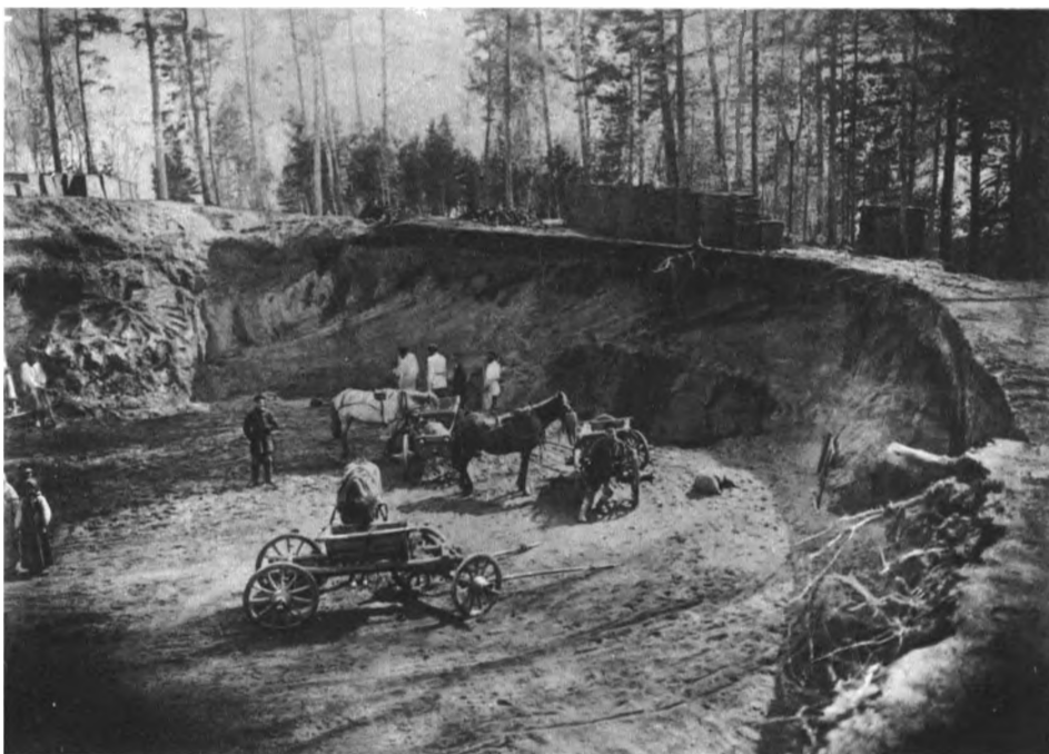
Котлован под церковью во Флёнове
