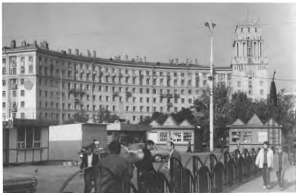
Дом у Калужской заставы в Москве. Левое крыло, на строительстве которого работал Солженицын. Фото 1990-х гг.
