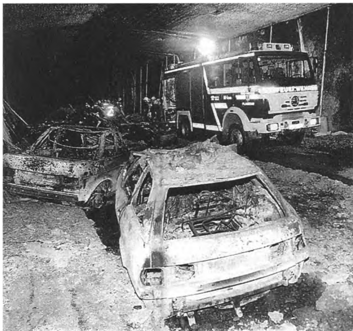
Последствия пожара в автотоннеле близ Зальцбурга (Германия), 1999 г.
