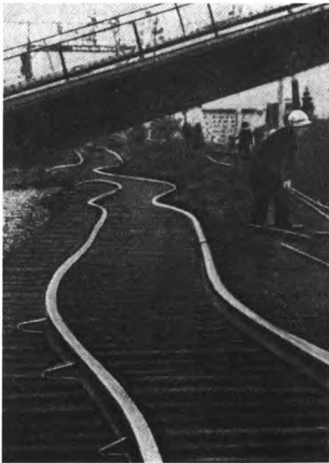
Рельсы железной дороги после землетрясения (Япония), 1956 г.
