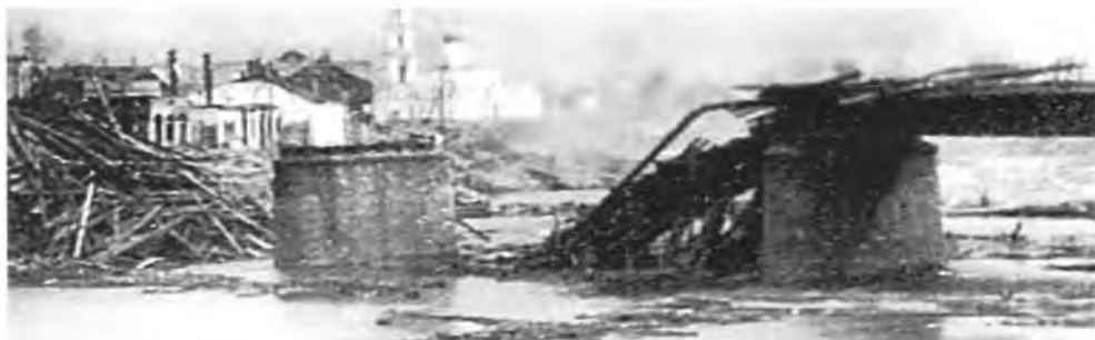
Старая Русса. Разрушенный мост
