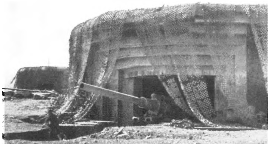
Каземат береговой батареи у городка Маркуф. Орудия калибром 210 мм, толщина стен каземата 4 м
