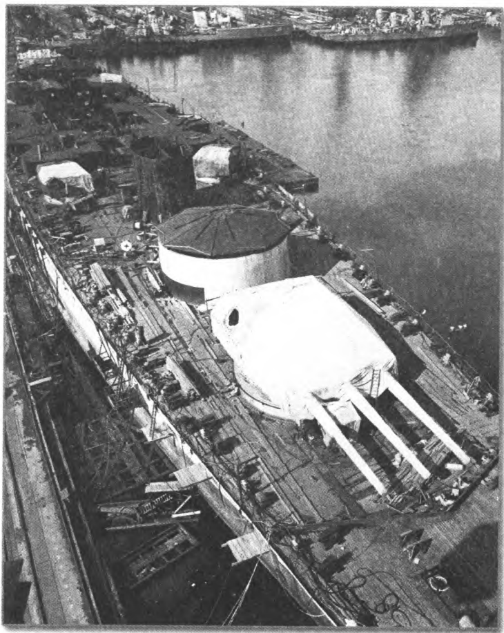
1937г. «Шарнхорст» на достройке. Уже установлены орудия главного калибра на башне «Антон»
