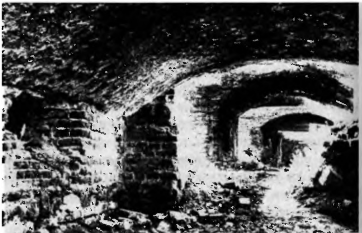
Оплавившиеся своды подвалов казармы 333-го стрелкового полка.
