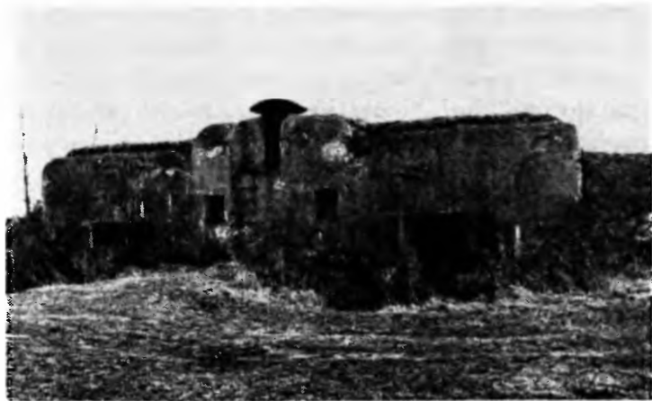
Форт V. Двухъярусный каземат для прислуги противотанковых орудий с наблюдательным колпаком.
