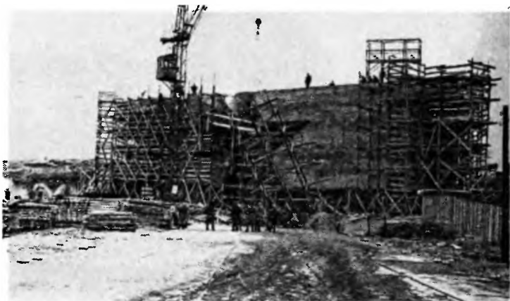
Строительство главного входа мемориала, 1971 г.
