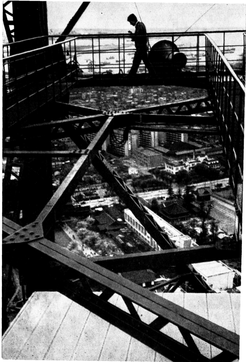
На телевизионной башне в Токио
