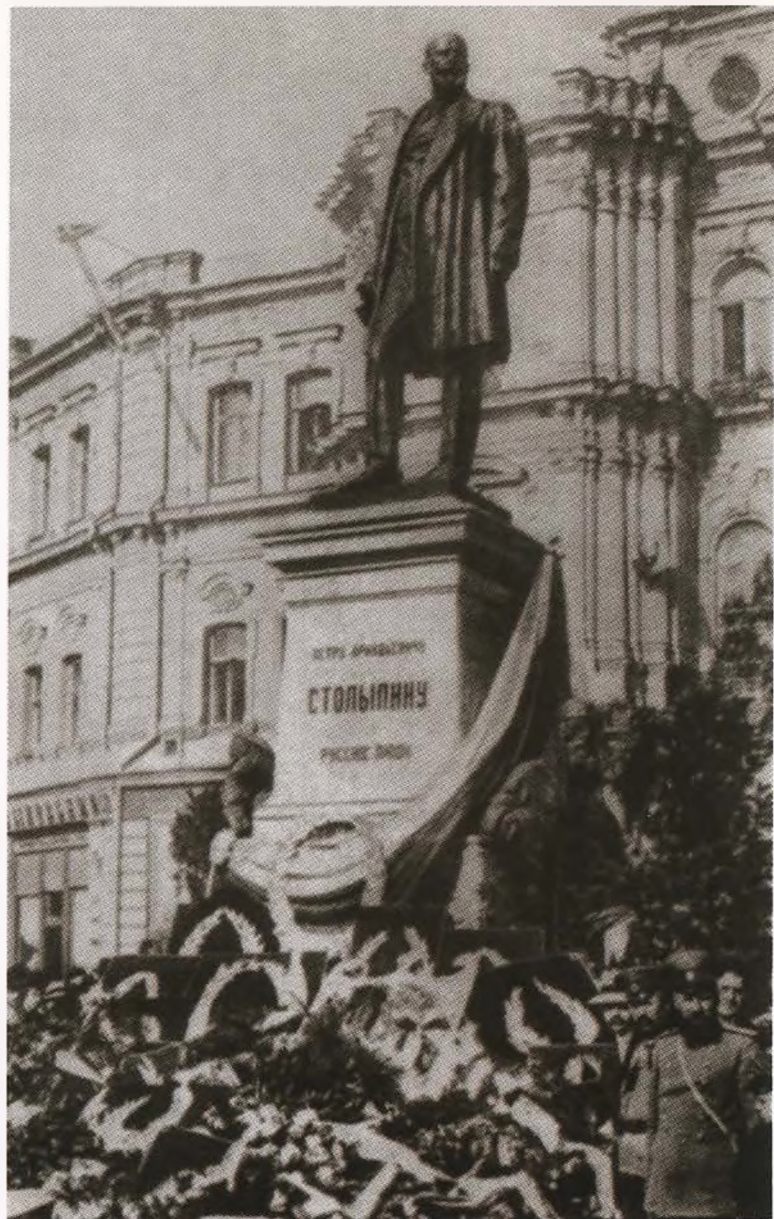
Памятник П. А. Столыпину, открытый 1 сентября 1912 года перед зданием Киевской городской думы.
